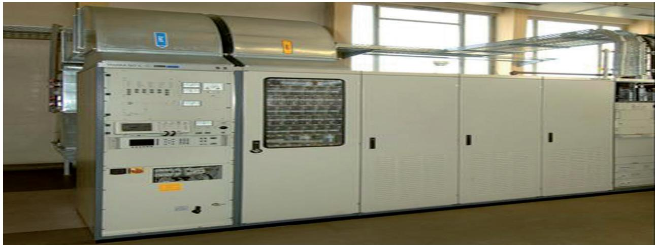
ภาพที่ ๕-๑๔ เครื่องส่งสัญญาณแบบกึ่งตัวนำ (Semi-conductor) ขนาด 50 kW
