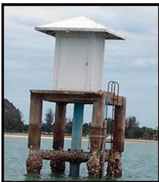
เมื่อวันที่ ๒๕ กรกฎาคม พ.ศ.๒๕๕๙ ได้ทำการทดลองติดตั้งเครื่องวัดระดับน้ำระบบดิจิตอลแบบทำงานด้วยการเปลี่ยนแปลงความกดดันน้ำอันเนื่องมาจากความลึก ตราอักษร MiniTroll หมายเลขเครื่อง ๑๙๑๕ คู่กับเครื่องวัดระดับน้ำเดิม เพื่อทดลองการตรวจวัดระดับน้ำด้วยระบบดิจิตอล โดยไม่ใช้เจ้าหน้าที่ในการดูแล
