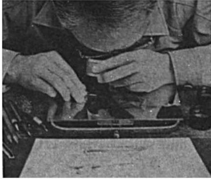
ภาพที่ 10.11 การแกะภาพหรือฉลวดลายบนโลหะ
