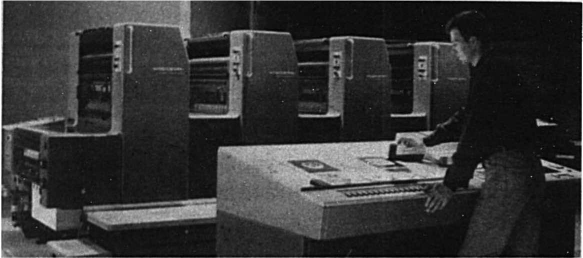
ภาพที่ 15.13 ตัวอย่างระบบควบคุมการทำงานวิถีไกลของเครื่องพิมพ์ออฟเซต
